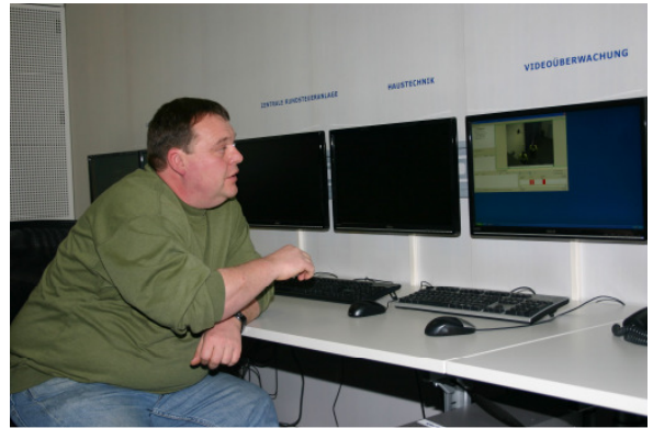
Nicht nur Wasserstände, auch die Daten der Objektüberwachung werden elektronisch übermittelt.
