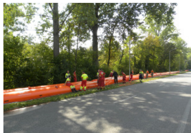
Aufgestellte Hochwassersperre im Gelände
