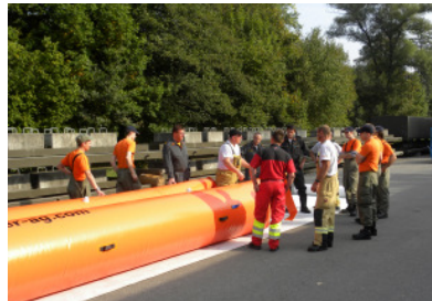
Aufstellen des Doppelschlauchsystems
