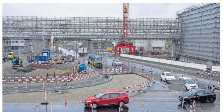
Coop: Während der Bauzeit liegt die Verantwortung bei Bränden noch bei der Ortsfeuerwehr Hunzenschwil-Schafisheim.
