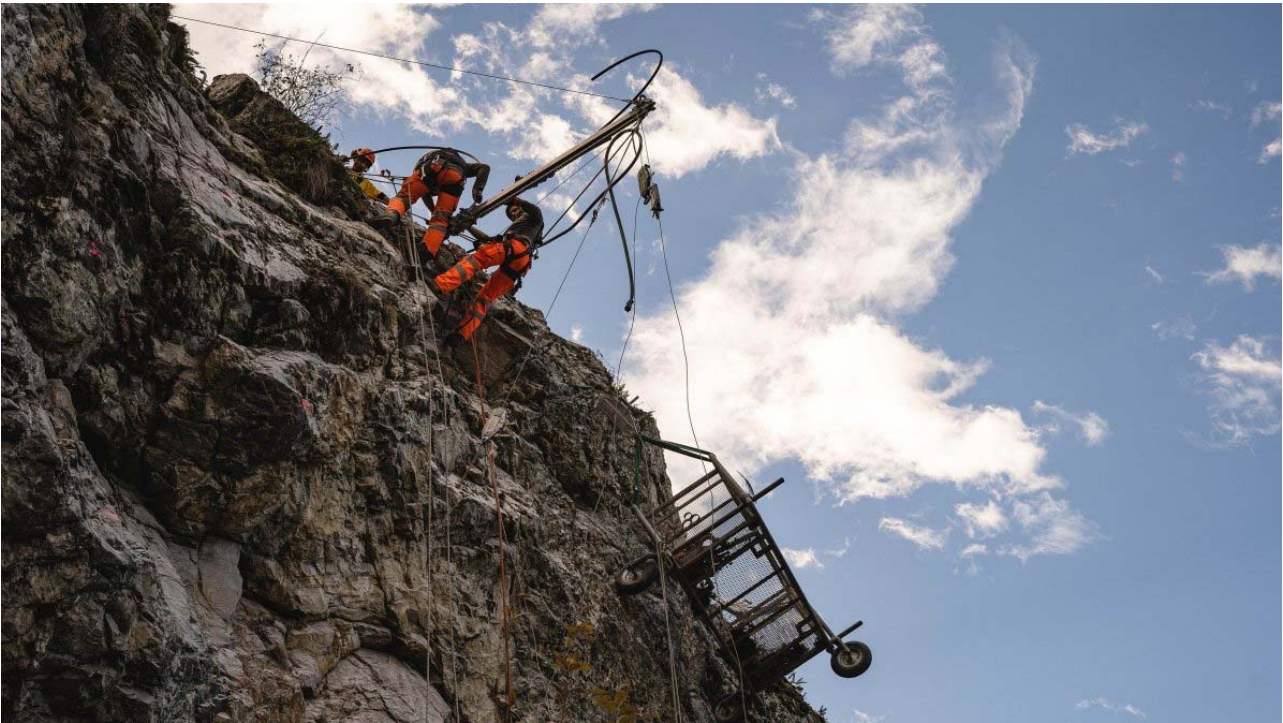
Hangsicherungsarbeiten beim Netzausbau im Wallis. Sicherheit hat bei Swissgrid oberste Priorität
